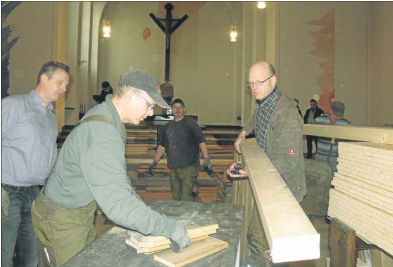
Bühnenaufbau für die Passionsspiele: Ludger Bücker, Ludger Rassenhövel, Heinrich Richard, und Robert Pöpsel beim Zuschneiden der Europaletten. zu sehen ist auch noch das in der Kirche bereitliegende Material und die Bühnenkonstruktion. ■ Foto: Zinselmeier
